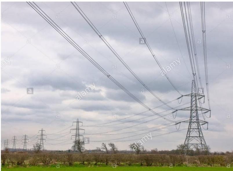
Esta función es una función coseno hiperbólico, y representa la situación real de un cable uniforme, flexible e inextensible que se suspende de dos puntos fijos, y forma, sujeto a su propio peso, una curva llamada catenaria. Este caso se presenta con frecuencia al calcular la longitud de los cables de alta tensión, que se encuentran suspendidos entre tramo y tramo de dos puntos fijos, ubicados en las torres de alta tensión. Para calcular la longitud se procede así:
